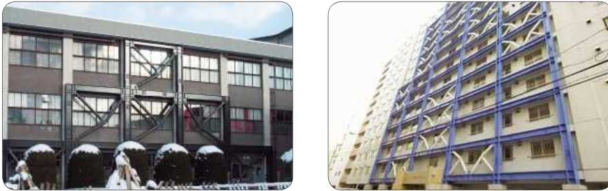
〈그림 2〉 일본 토금제진시스템 보강 사례
